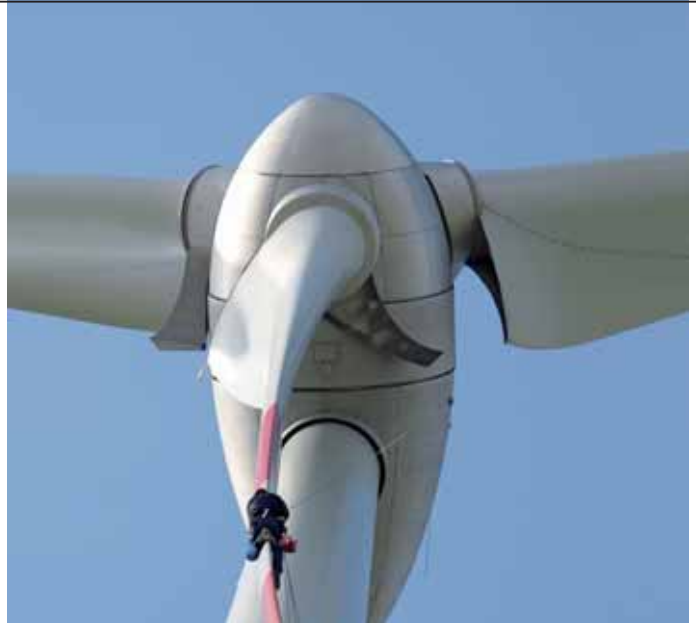
Zustandsprüfung einer Enercon-Windenergieanlage
