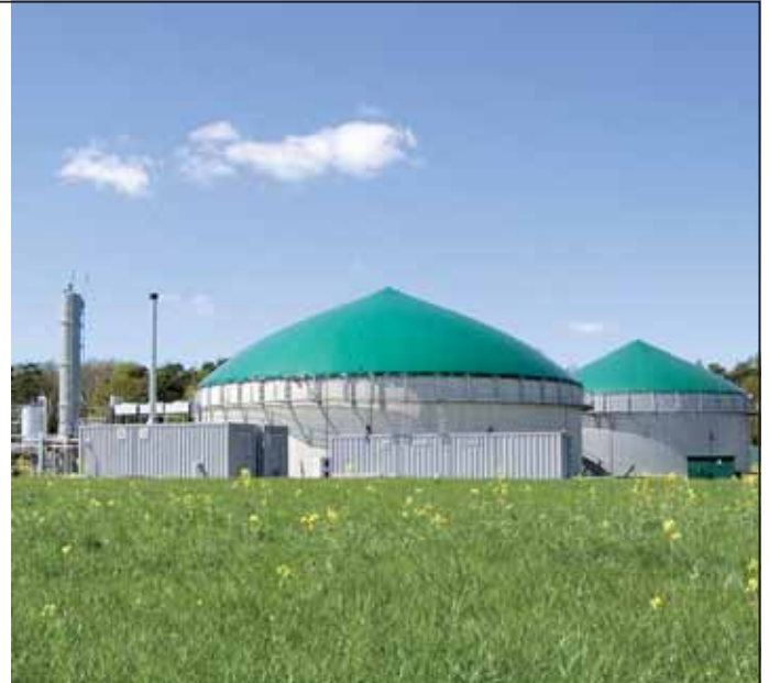
Landwirtschaftliche Biogasanlage mit vorgeschalteter Methanaufbereitungstechnik
