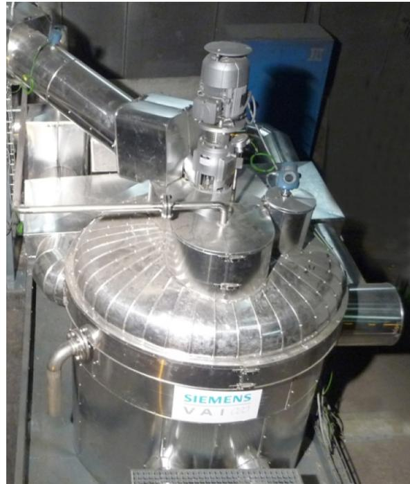
Abbildung 27: Salzspeicher zum Puffern Abwärme, Bild: (Innovationsmagazin hitech, Siemens AG 2012)
